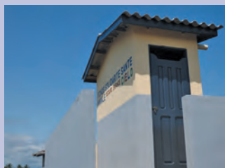
TOGO : Construction de latrines scolaires.
