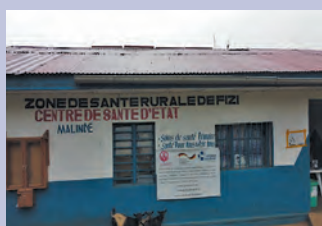
RD CONGO : Électrification du centre de santé de Malinde.
