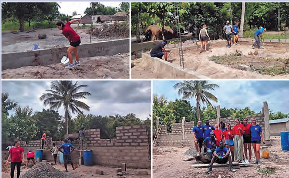
Construction du dispensaire.
