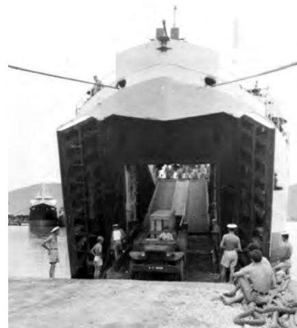
Débarquement dans le port de Saïgon.
