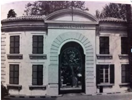
Hôpital Chalucet, Toulon. Porte d'entrée (DR).
