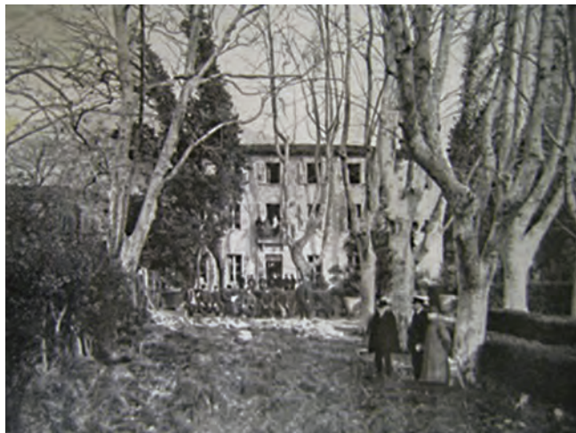
Villa Krantz, ancien chemin de La Valette.
