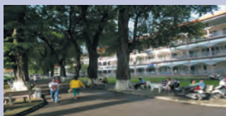
VIETNAM : Hôpital Nhi Dong 2 (ancien Hôpital « Grall »).
